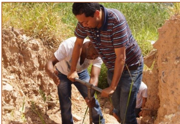
Figura 3: Coleta e acondicionamento de solo, com o auxílio do trado e saco plástico
