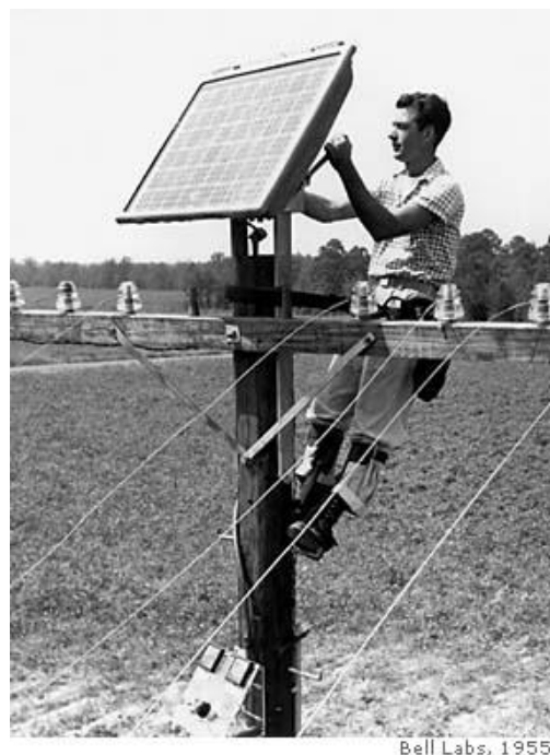
Figura 5: Primeira utilização de placas fotovoltaicas aplicadas a uma rede telefônica.
