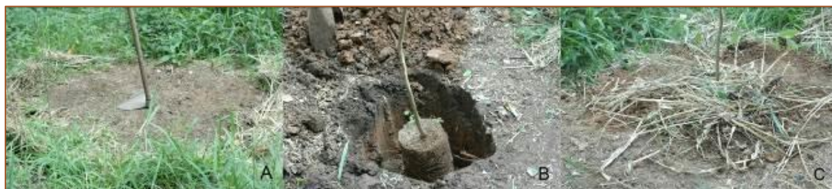
Figura 4: Limpeza do local e remoção das gramíneas (A); Plantio (B); Forma de Conservação da Umidade (C).
