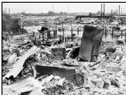
Figura 2.3 – “Tragédia em Vila Socó”.
